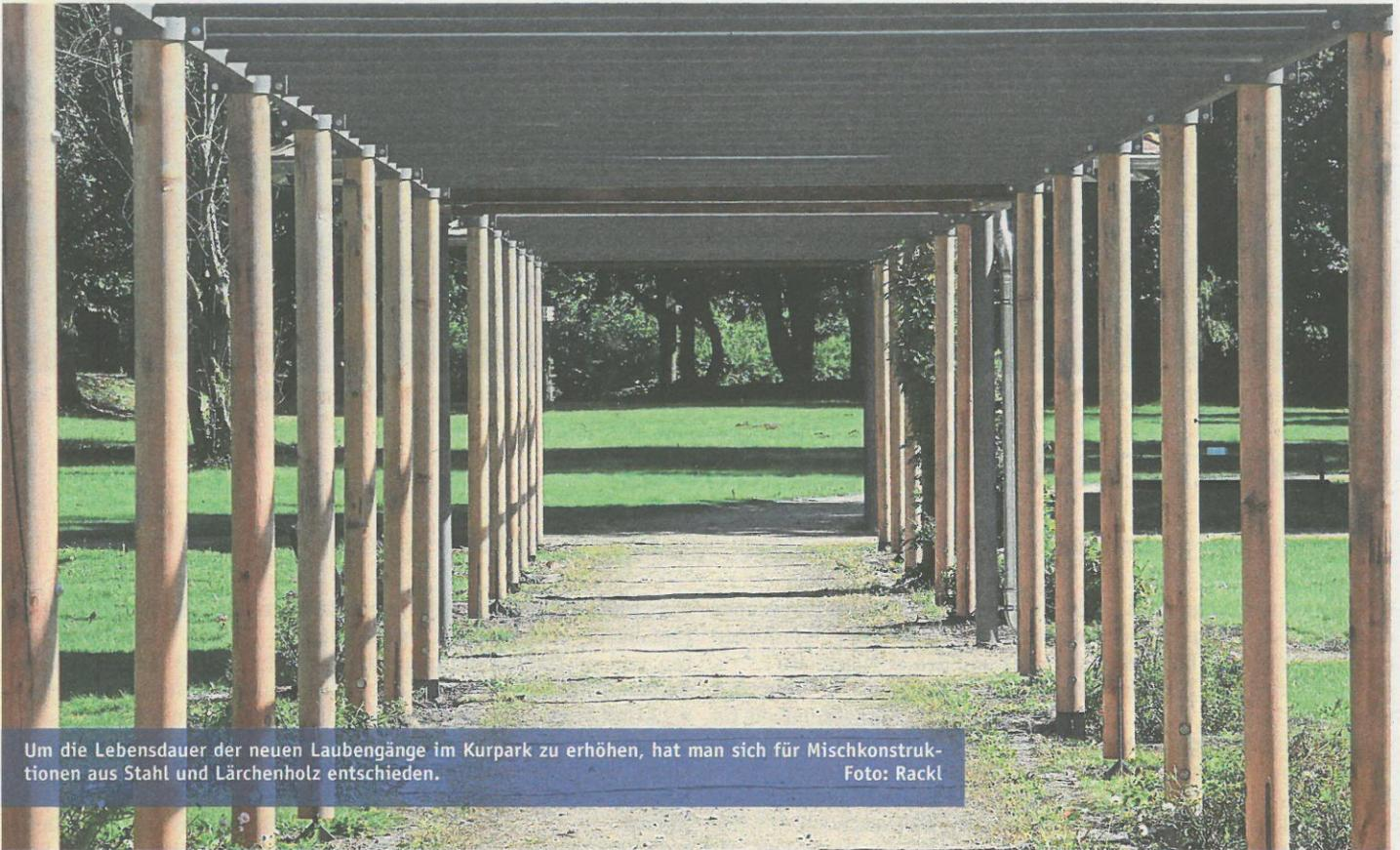
Um die Lebensdauer der neuen Laubengänge im Kurpark zu erhöhen, hat man sich für Mischkonstruktionen aus Stahl und Lärchenholz entschieden.
